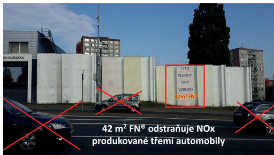
Obr. 1: Stěna na Barrandovské spojnici v Praze ošetřená multifunkčním nátěrem FN® s mimořádně silným fotokatalytickým efektem
