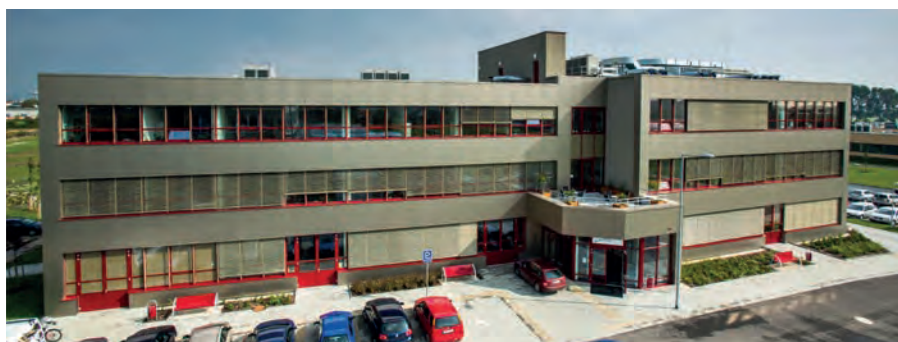
Obr. 2: Budova RCPTM v Olomouci
