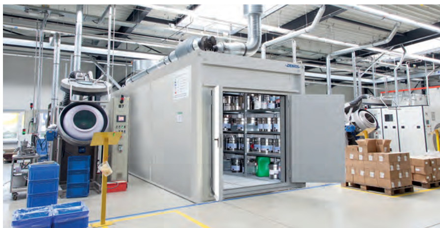
Obr.: Pochůzný protipožární sklad WFP
