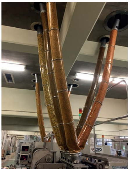
Obr. 8: Náhrada potrubí rukávovým spojem BFM Fitting
