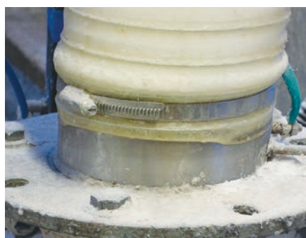
Obr. 5: Spoj BFM Fitting bez prašnosti
