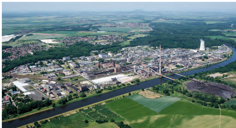
Obr. – Letecký snímek areálu společnosti Spolana a.s. v Neratovicích
