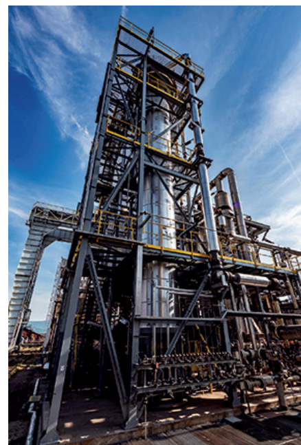
Obr.: Zmodernizovaná výroba čpavku ve výrobním areálu ORLEN Unipetrol v Litvinově
