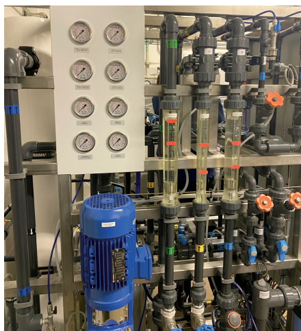
Obr. 2: Jednotka RO typ WEDRO 2, s EDI, návrhový průtok 1,5 m 3 /h, 2 moduly.
