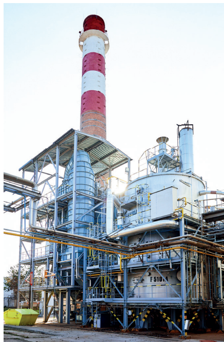
Obr. 2: Spalovna odpadních kalů z rafinerie Slovnaft, termoolejový okruh.
