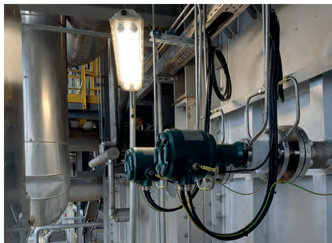
Obr. 8: Provoz EJ, Orlen Unipetrol RPA s.r.o. v Litvínově
